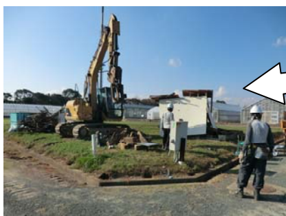
古い気象センサーを撤去中
